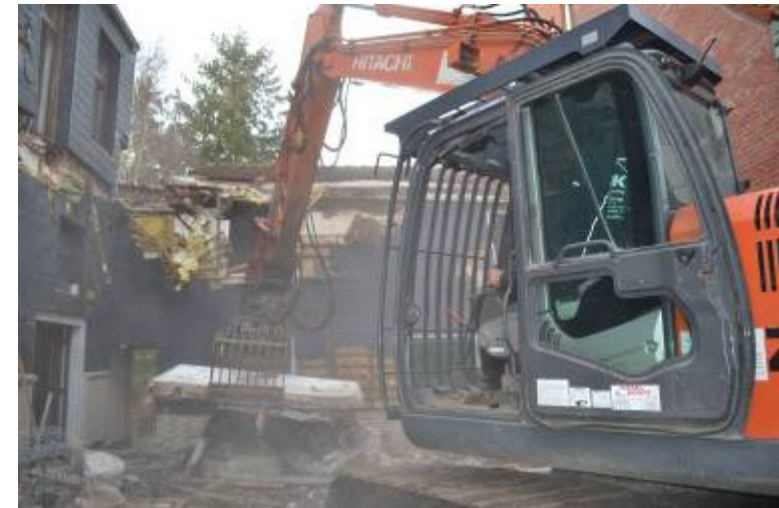
Abrissarbeiten Quelle: Region Dithmarschen
